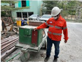
ไม่มีถังดับเพลิงประจำเครื่องเชื่อม
