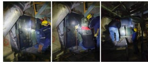
งานปะ Chute biomass Calcine C2 ชั้นU-1
