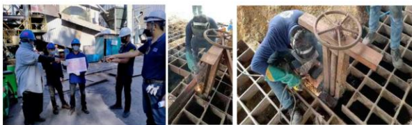
งานเชื่อม Slide Gate อ่าง Biomass
